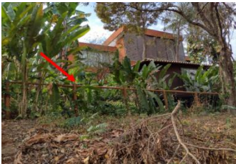
Figura 8. Vista do terreno do imóvel a partir do terreno vago nos fundos. Cerca divisória. Fonte: os autores.
