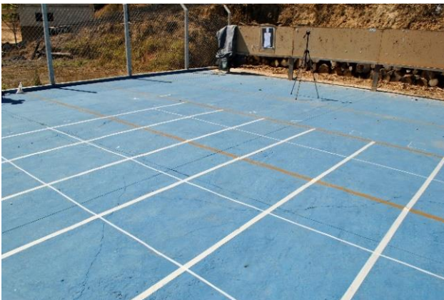
Figura 3: Fitas brancas marcando o concreto.
