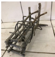
Figura 3. Detalhamento do consolo C4 encontrado in loco . Fonte: Autores
