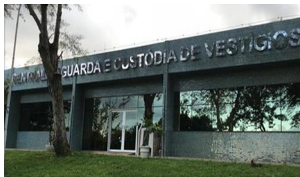
Figura 1. Edifício Sede da CGCV/DPT/PCDF.
