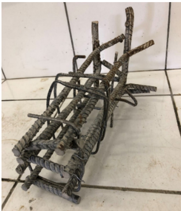
Figura 6. Detalhamento do consolo C4 encontrado in loco . Fonte: Autores
