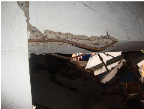
Figura 6. Efeito dos esforços de tração na viga.
