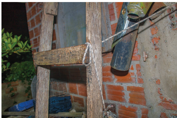
Figura 4. Fotografia registrada no momento da perícia mostrando laço que a corda fez na lateral do degrau da escada.
